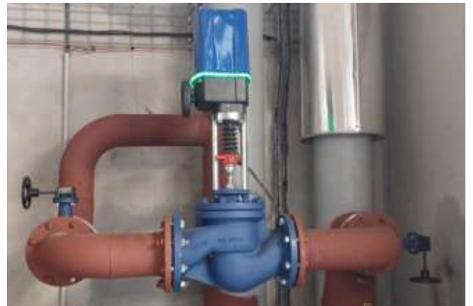
Mise en place vanne by-pass de la Géo
