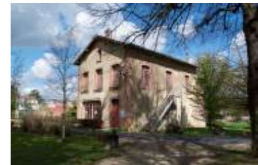
35 Annexe du château Soubiran Parc du Château Soubiran
