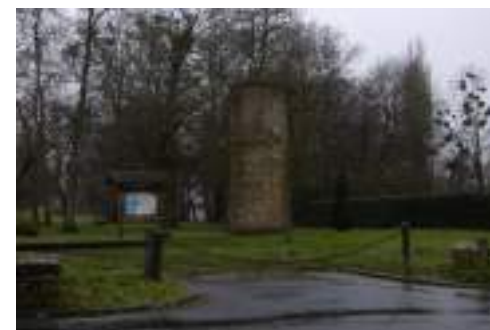
53 Réservoir du parc de Farcy
